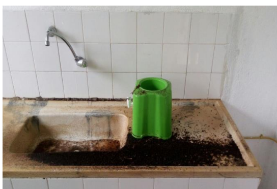
Imagem 6.3.1.12 Pia da cozinha coberta de fezes de morcego
