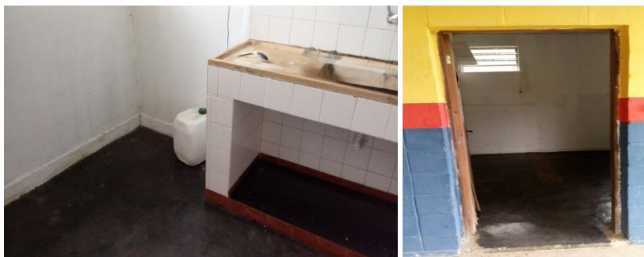
Imagens 6.3.1.11 Cozinha em condições precárias e sem equipamentos
